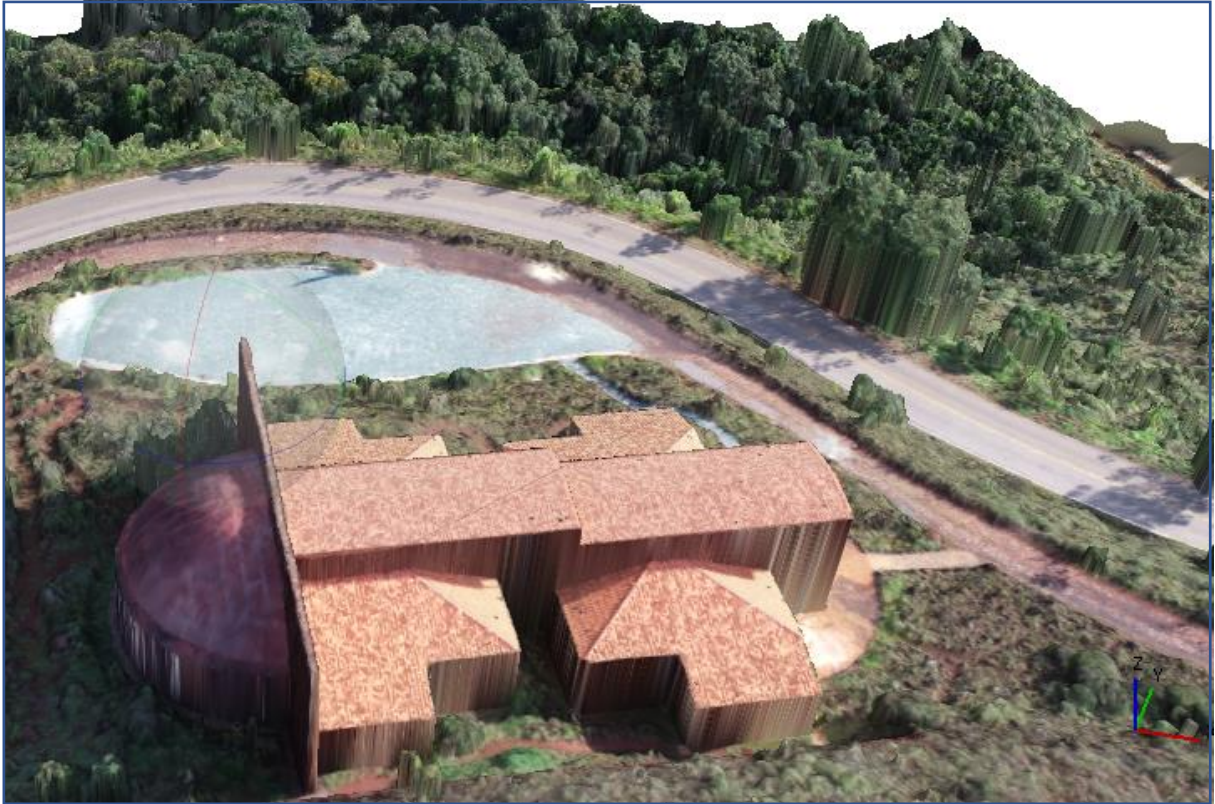
Figura 13 – Modelo 3D da obra gerado pelo aplicativo Agisoft
